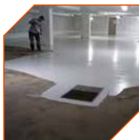
Garagegolv BRF Postiljonen
