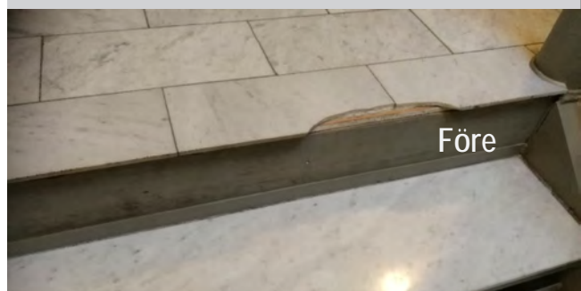
Skadad trappnos blir renoverad
